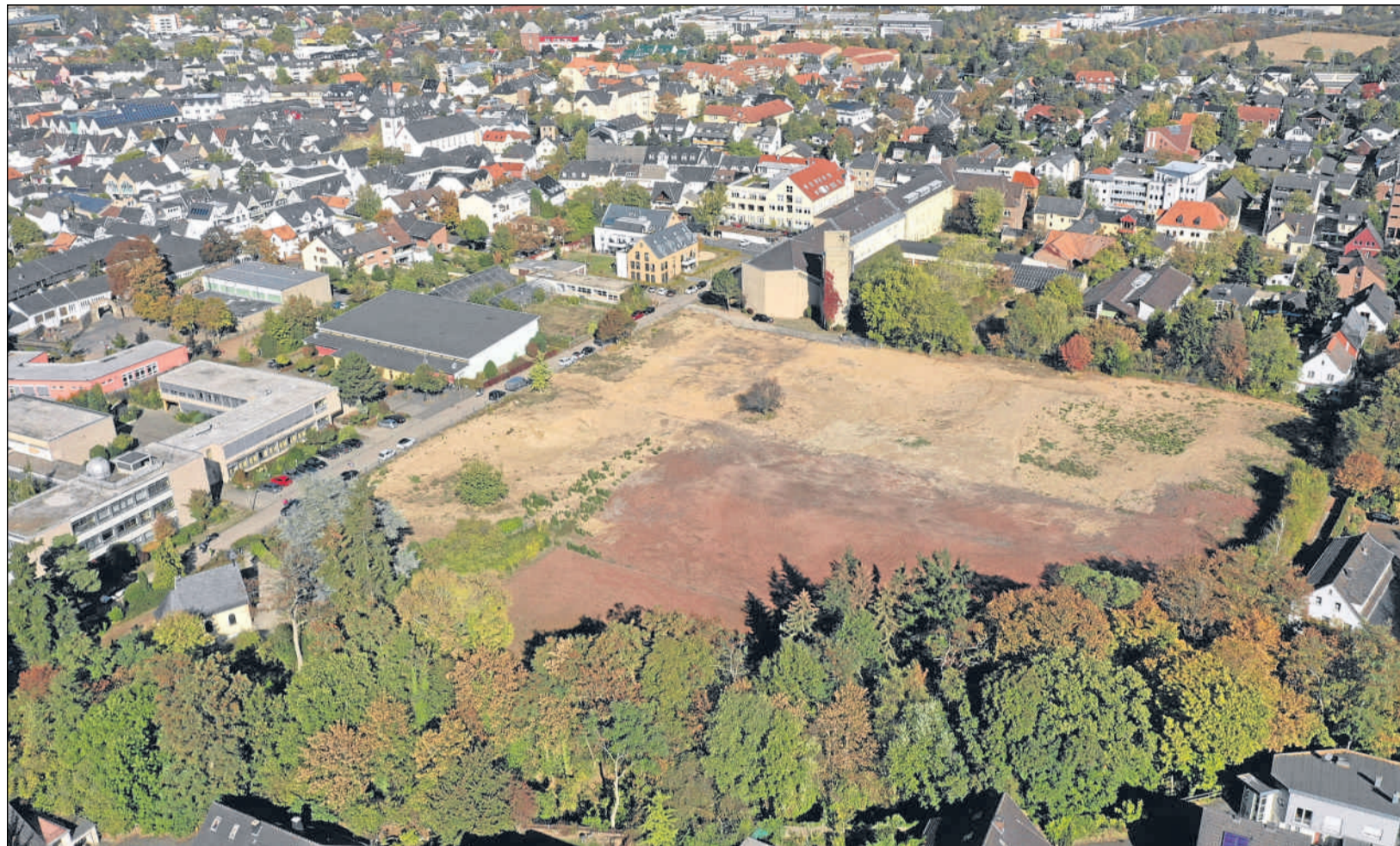
Rund 30 000 Quadratmeter Fläche misst das Baugebiet auf dem ehemaligen Pallotti-Areal, hier aus der Luft fotografiert.
