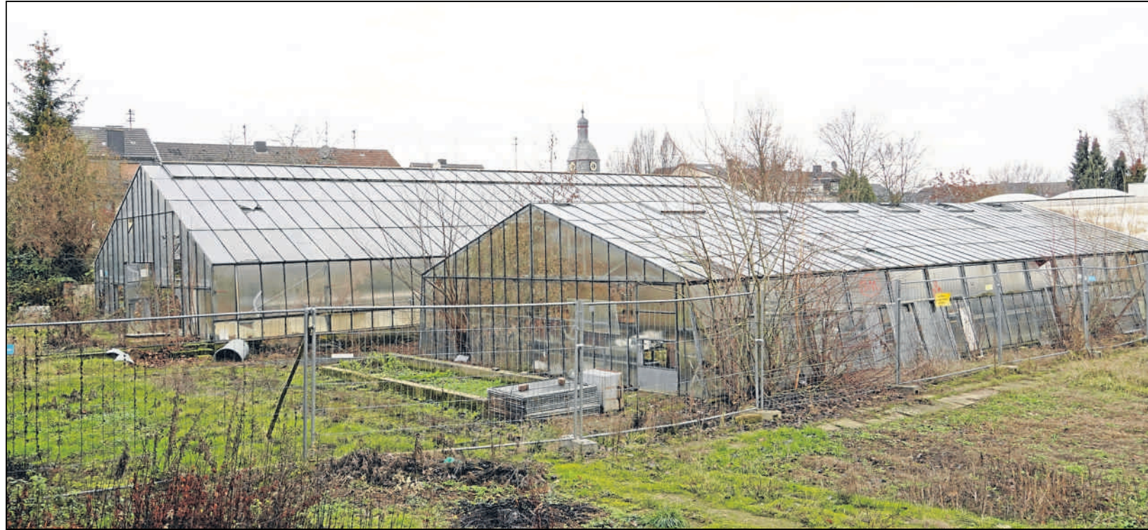
Auf dem früheren Gärtnereigelände des Vinzenz-Pallotti-Kollegs in Rheinbach sollen Arztpraxen und Wohnungen entstehen.
